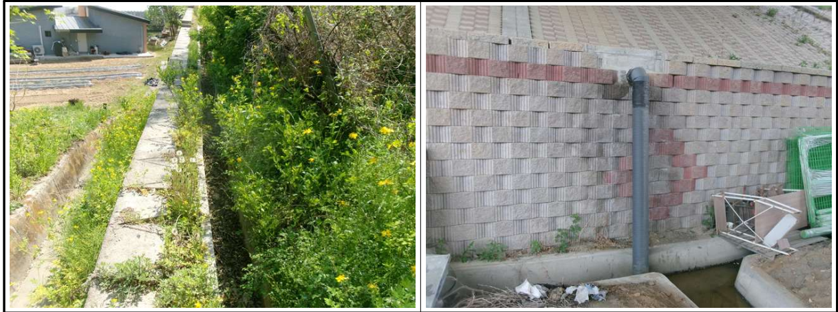
【사진 1.3.3】 배수시설 전경
