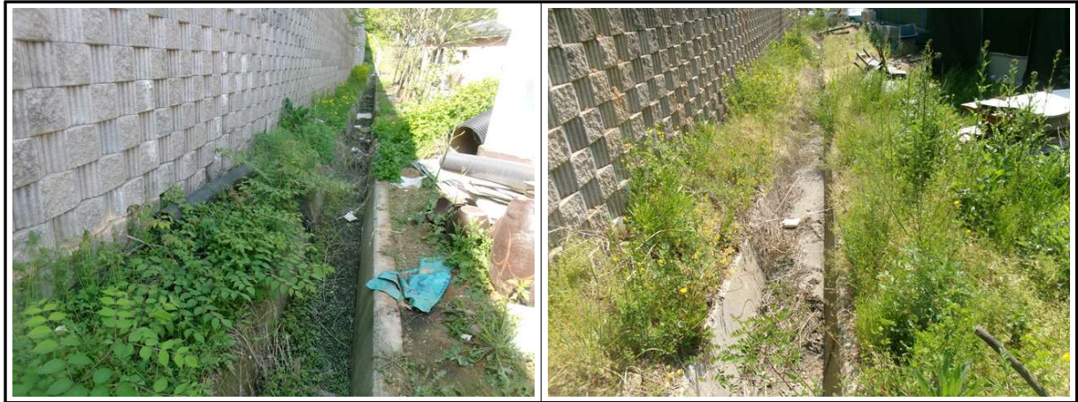
【사진 1.3.1】 지반, 기초부 전경
