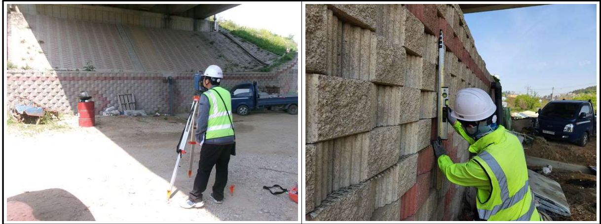
【사진 1.4.2】 측량작업 전경
